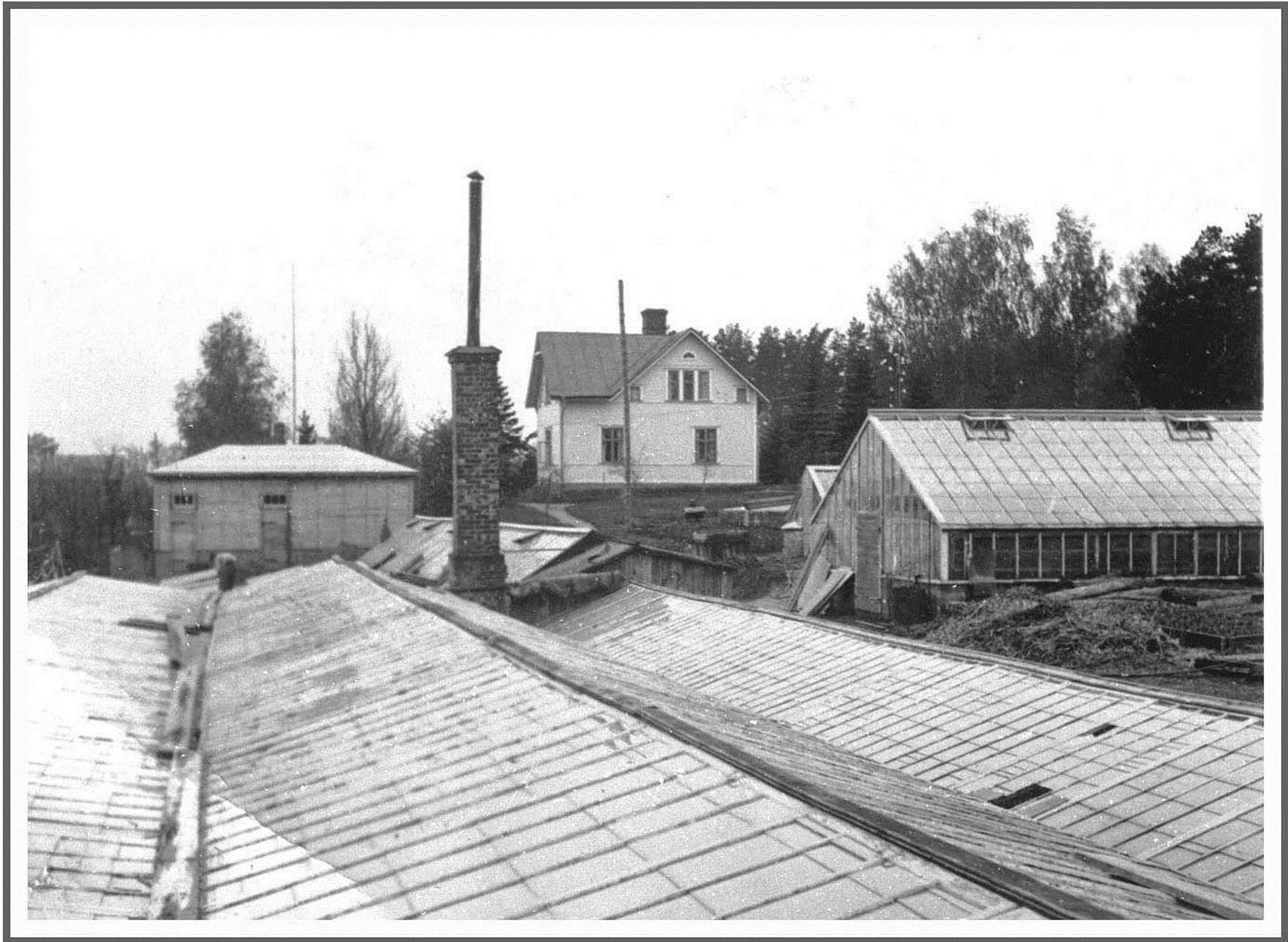
Bilden är troligen tagen på slutet av 30-talet, kanske omkring 1940. Här ser vi brygghuset t.v. i bakgrunden, ännu omålat, och en ny panncentral med hög skorsten har uppförts vid de nedre växthusen. Till höger är växthusen 1, 2, 3, och bakom skorstenen den lilla låga 5:an. I framkanten växthusen 6, 7 och 8. Det hus som senare kom att kallas 4:an finns ännu inte i högra kanten. Det byggdes omkring 1945.
